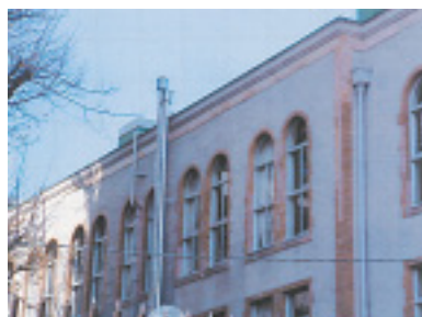
樟溪館・3階のアーチ窓
